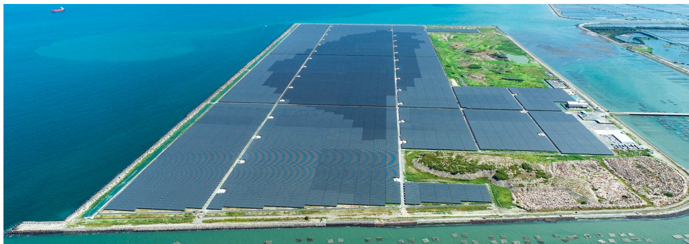
272 MW E2 Solar Project in Taiwan
